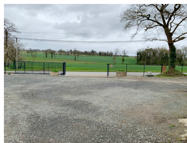
Réfection de la cour devant l'atelier.
