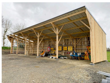
Le nouveau hangar.
